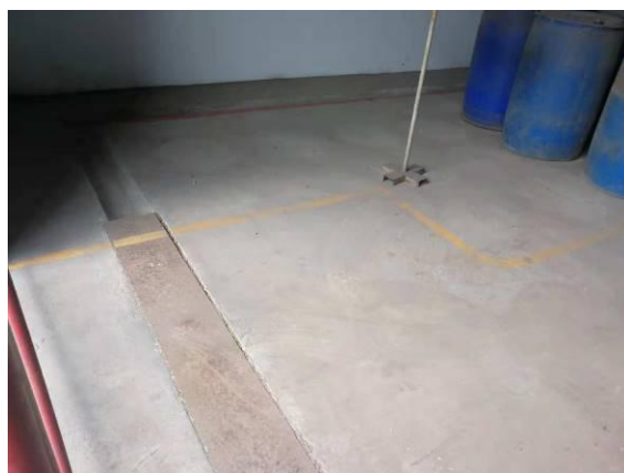
图 5.3-8 仓库内地面防腐
