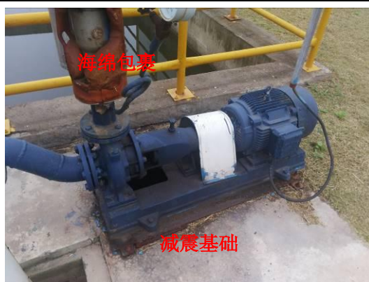
图 5.3-6 水泵减震消声措施
