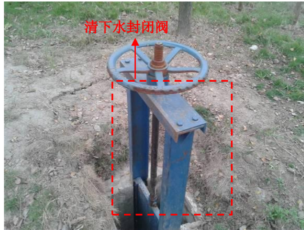
图 5.3-2 初期雨水池及清下水切换阀
