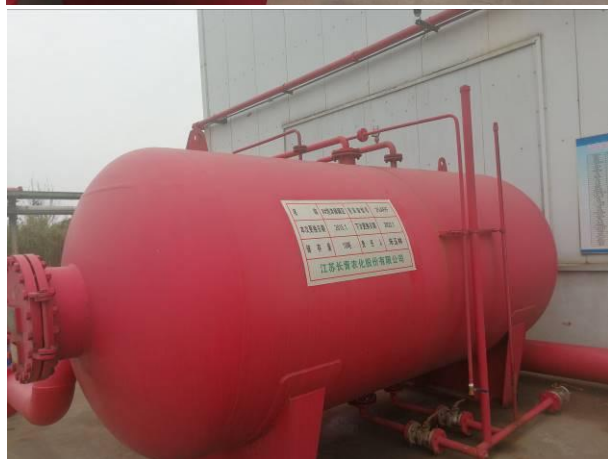
图5.2-4 消防泡沫储罐
