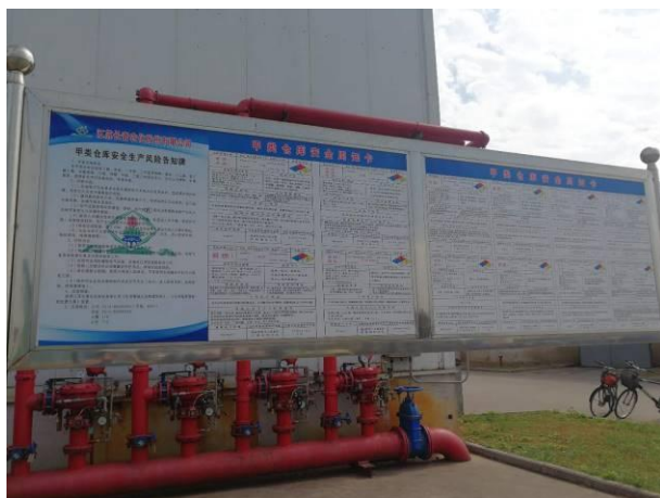
图 5.4-6 重大危险源处设立了安全标志和消防标志
