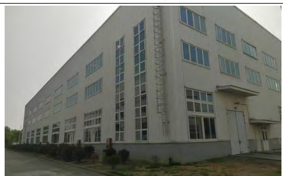
老厂区丙类仓库
