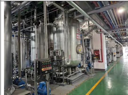
生产车间地面防渗
