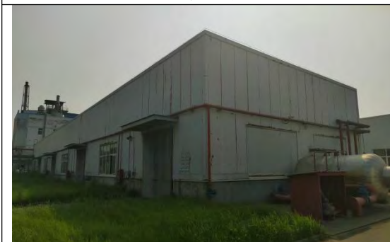
老厂区甲类仓库
