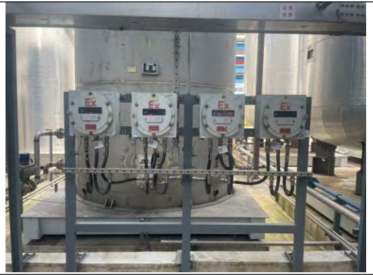
储罐区安全应急告知卡及应急监测报警装置
